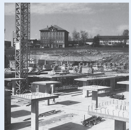
Das Gelände nach dem Abstossen des Humus und nach der Betonierung der pilzförmigen Stützen der unterirdischen Einstellhalle, übrigens der grössten dieser Art in Bern.
